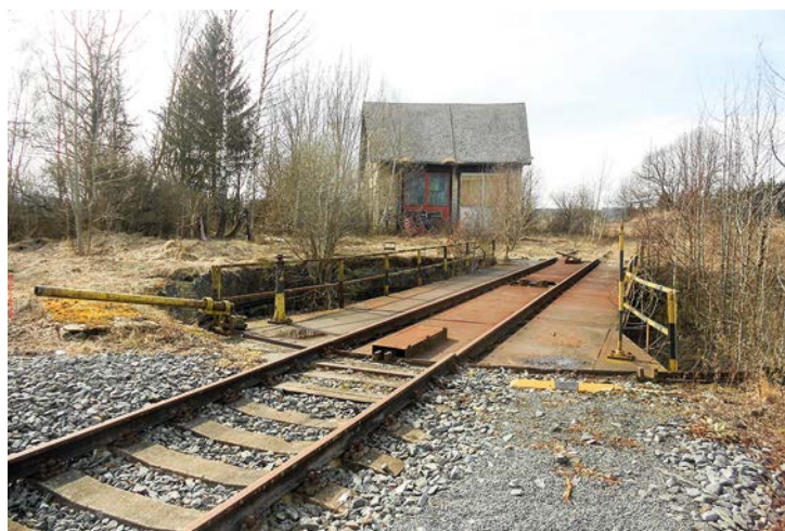
Chybí některé díly, nikdo točnu nemaže, léta je ve stejné poloze. V pozadí již zmíněná výtopy. Není využita.... (Foto Václav Kohout, jaro 2018)
