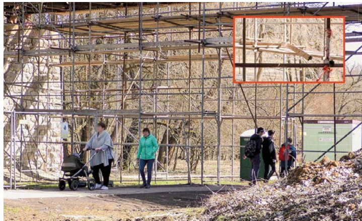
Aktuální stav železničního mostu u Ferdinandova pramene. Foto redakce
