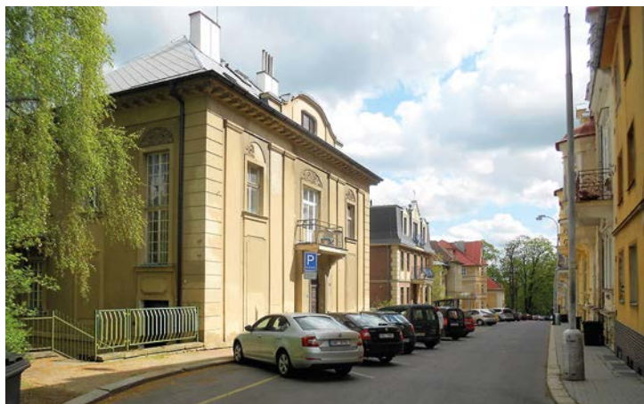
Dům Junák v ulici B. Němcové. Vpravo dolů je řada domů, jsou zajímavé tím, že sice mají zdánlivě různou architekturu, ve skutečnosti ale mají stejné vnitřní členění.
