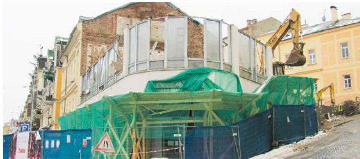
Demolice obchodního domu Baťa 2015. Foto archiv redakce
