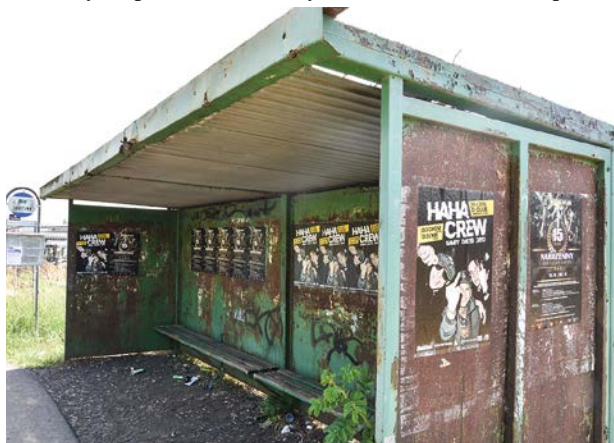
Stávající stav plechového přístřešku zastávky na Plzeňské ulici. Foto David Kurc
