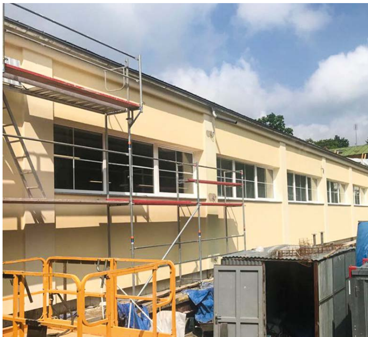
Ve stáčírně u Ferdinandova pramene probíhají dokončovací práce rozsáhlé rekonstrukce. Foto Bohemia Healing Marienbad Waters
